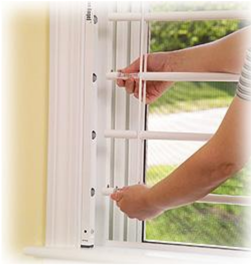
Figura 1. Instalação de um protector de janelas
