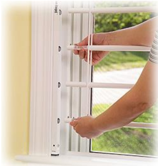
Figura 1. Instalación de un protector de ventana
